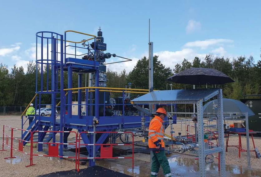
Plateforme de **stockage souterrain de l'hydrogène**, au centre la tête de puits EZ53.
